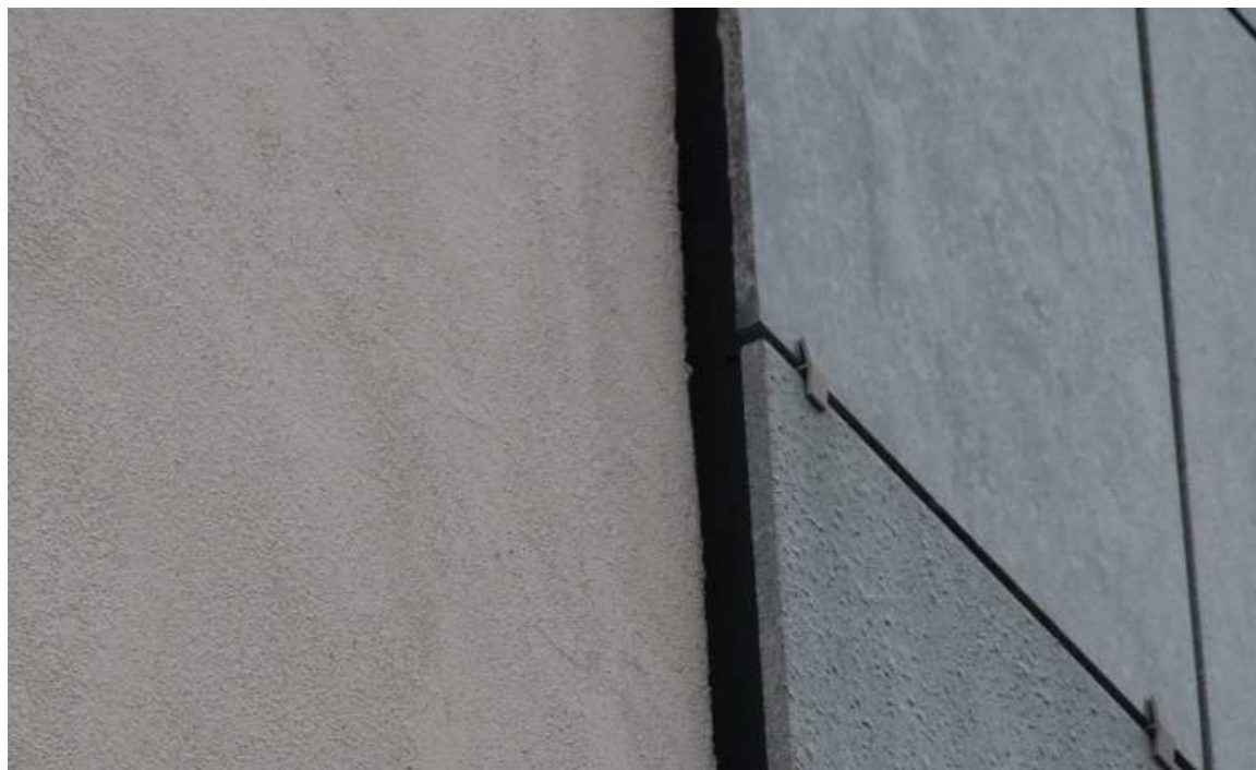
Detail zakončení obložení na západní stěně
